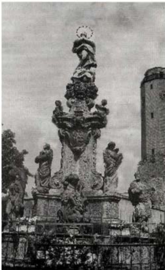
Die Mariensäule vor dem 1945 zerstörten Rathaus
