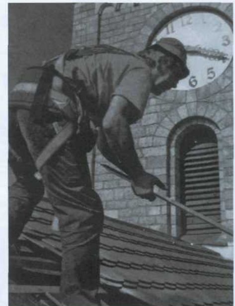
Dacharbeiten an St. Andreas
