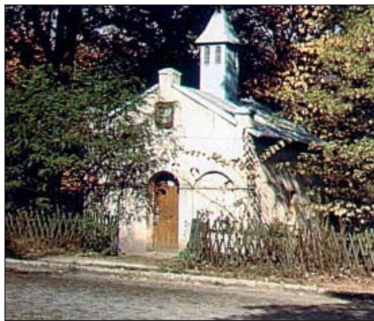
Die Kapelle vor und nach der Renovierung
