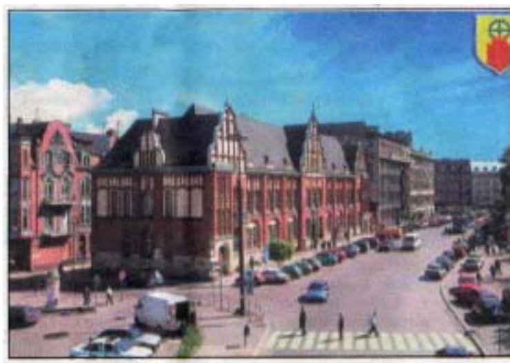
Umbau des Bahnhofplatzes
